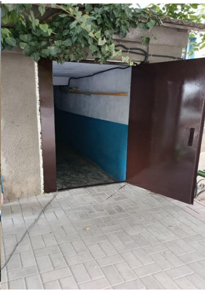
К/З Дом №23 (1-йподъезд)
