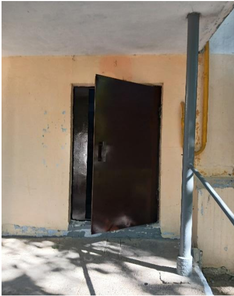
К/З Дом №21(3-й подъезд)
