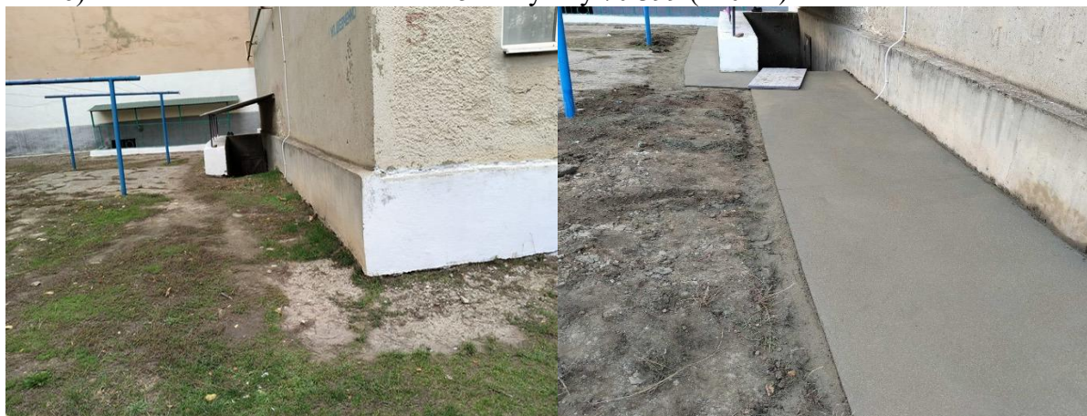
6) Ремонт отмостки Шевченко 5 на сумму 70 399 (120 м 2 )
